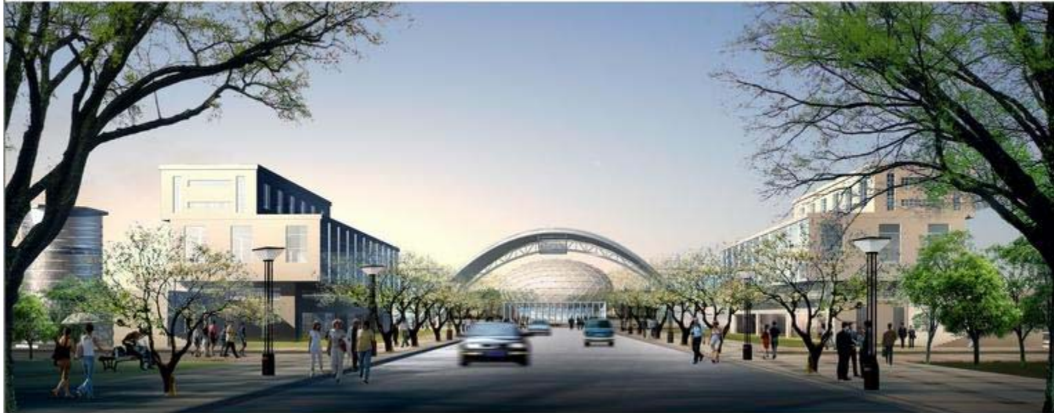
Blick auf die zentrale Ost - Westachse mit Verwaltungs- und Serviceeinrichtungen
